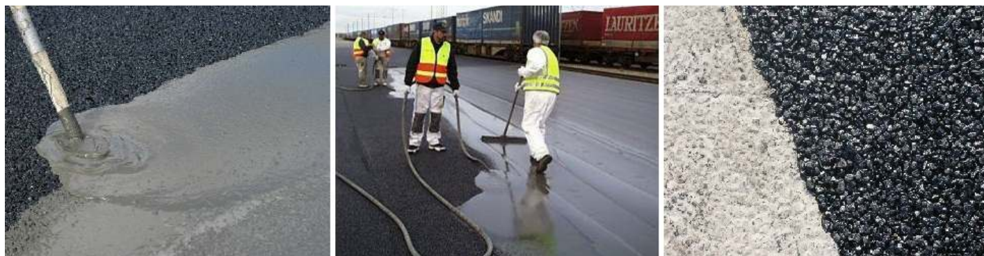
Faze de instalare ale sistemului CONFALT
